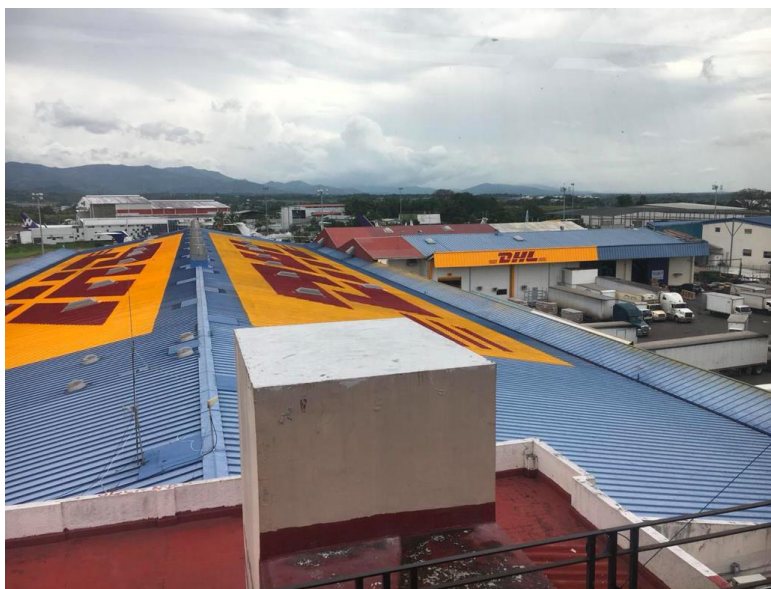
Fotografía 1. Bodegas de DHL dentro del aeropuerto internacional de Panamá Tocumen.
