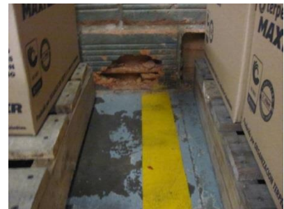
Figura 16: Agujeros en las paredes
