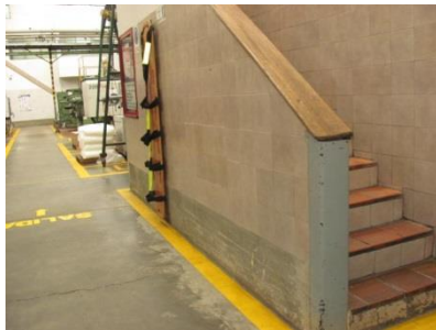
Figura 18: Paredes con baldosa y en la parte inferior pañetadas
