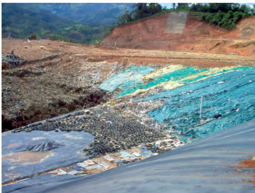
Foto 10. Vaso La Carrilera. Relleno Sanitario La Pradera
