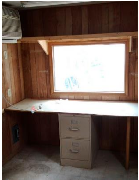
Anexo 4. Área de empaque contenedor
