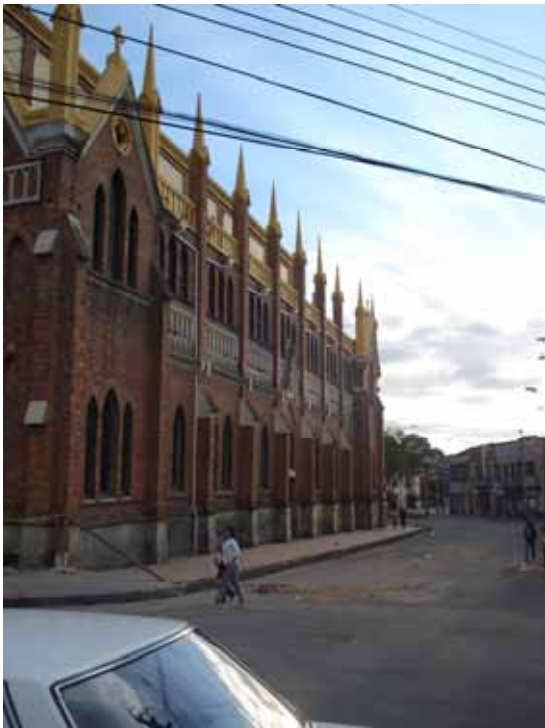
vista que toma la calle 44 desde la carrera 18.
