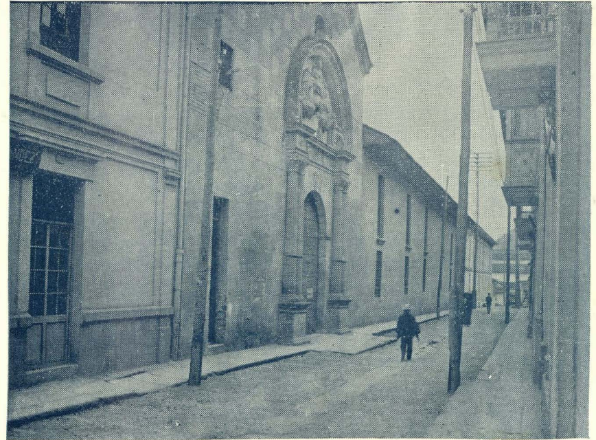
Fachada de la Capilla
