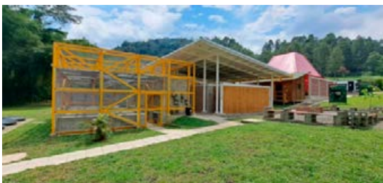
Estación Experimental Fase 2, sede La Vega: obra nueva Área: 1732 m 2 Finalización: enero de 2023
