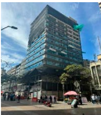
Torre 3 Los Ángeles: reforzamiento estructural y adecuación Área: 6847 m 2 Ejecución de la obra: 60%
