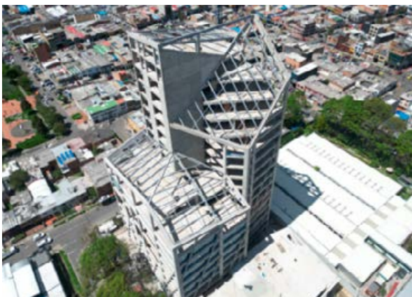
Edificio UR LABS sede Quinta Mutis: obra nueva Área: 26 600 m 2 Ejecución de la obra: 33%
