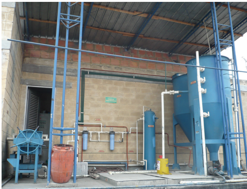
Planta de tratamiento de aguas residuales, entregan el agua clarificada a las cañerías de aguas de la ciudad de Bogotá.
