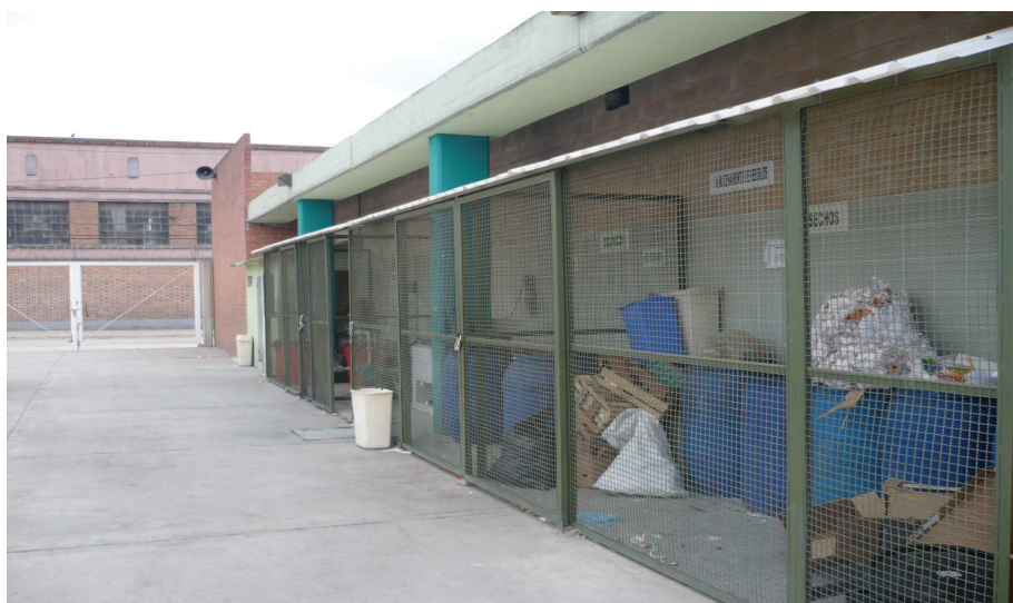
Una zona de clasificación de residuos así como un tanque de purificación del agua hacen parte de este proyecto.
