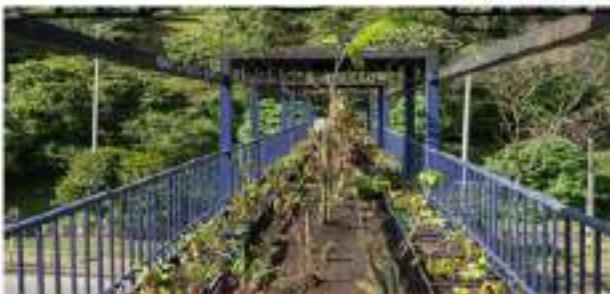
En la Calle 33 de Medellín fue instalado un puente ecológico
