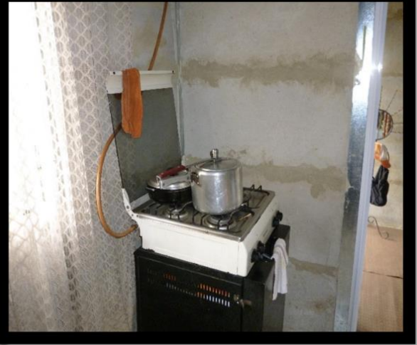
Imagen 31. Cemento para cubrir hendiduras.
