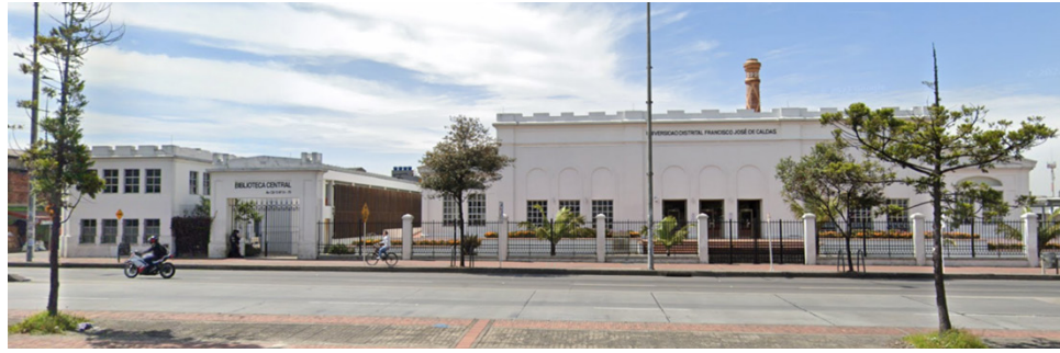
Imagen No. 14: Universidad Distrital Francisco José de Caldas sede Aduanilla de Paiba, antiguo matadero distrital - BIC. Fuente: Google Earth, enero 2022.
