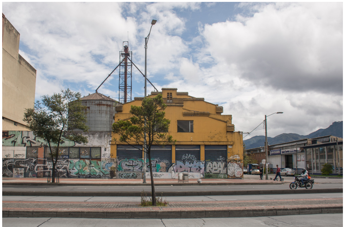
Imagen No. 58: Estado actual costado Calle 13 Unidad única de Actuación Urbanística Fuente: Instituto Distrital de Patrimonio Cultural - IDPC, 2020.
