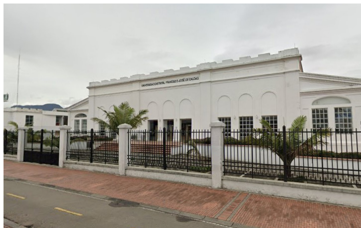
Imagen No. 31: Universidad Distrital Francisco José de Caldas sede Aduanilla de Paiba, antiguo matadero distrital Fuente: Google Earth, abril 2022.
