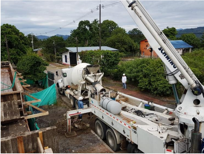
Registro Fotográfico obra
