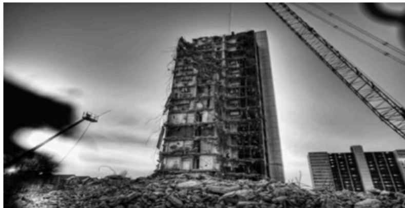
Figura 2. Demolición del conjunto Cabrini, Chicago
