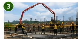
Vaciado de concreto en zapatas 15/01/2027 – 02:20 p.m.
