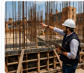
Revisión de estructura Verificación de armado y recubrimientos.
