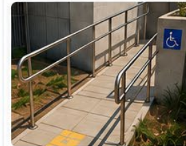
Verificación de accesibilidad Cumplimiento de pendientes, ancho y textura PMR.
