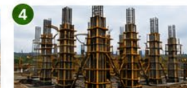
Construcción de columnas 15/01/2027 – 04:10 p.m.
