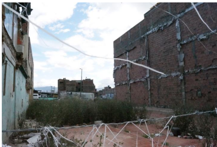
Terreno de las demoliciones de los edificios del antiguo Bronx Fotografía de Pablo Morales Mosquera
