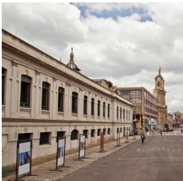
Edificio de La Flauta Fotografía Cortesía Fundación Gilberto Alzate Avendaño
