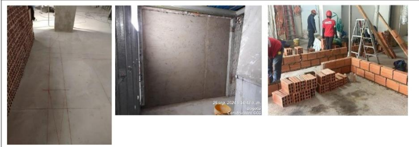
Muros y divisiones Replanteo e instalación de muros en estructura liviana y mampostería según diseños.
