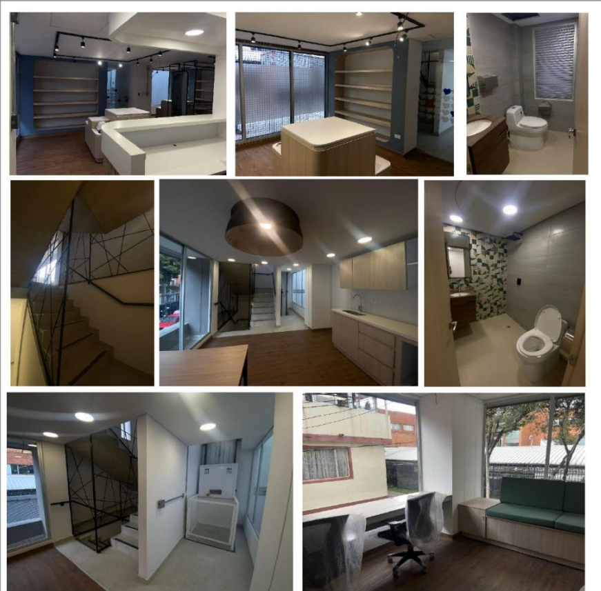
Acabados, instalación de mobiliario y remates Instalación de pisos, enchapes, papel de coladura, instalación de muebles, luminarias y demás acabados.
