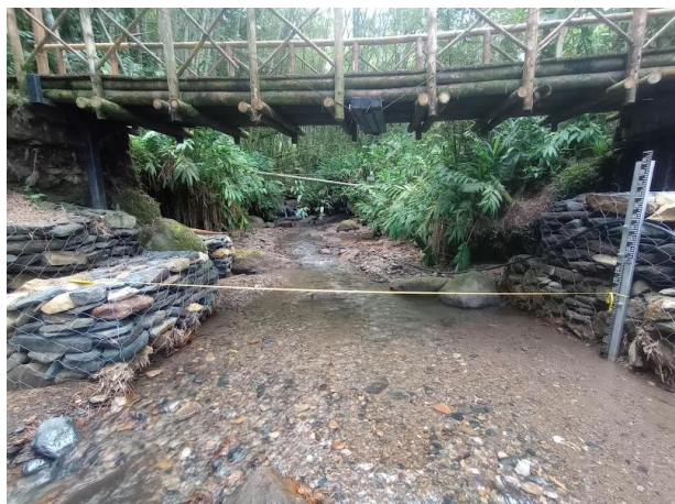
Fotografía 11. Aforo de caudal
