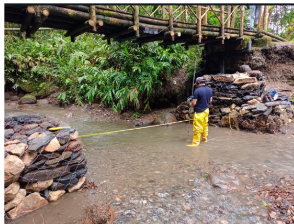
Fotografía 8. Aforo de caudal
