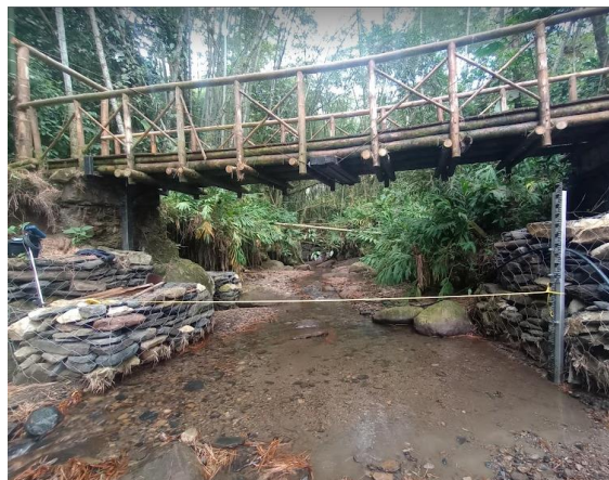
Fotografía 20. Aforo de caudal
