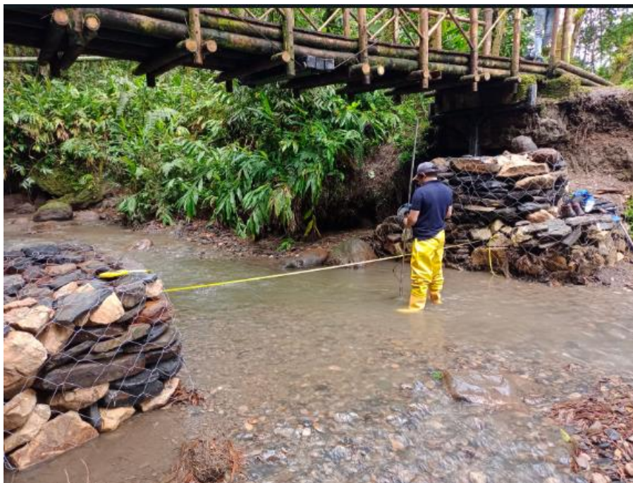
Fotografía 2. Aforo de caudal
