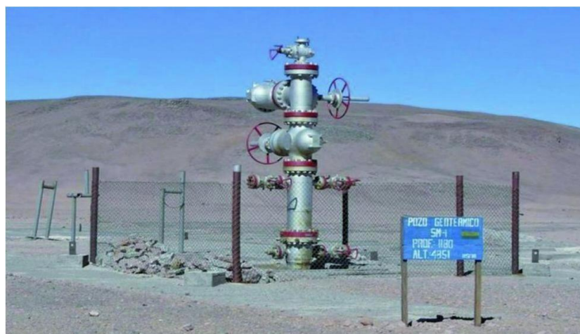
Figura 6. Pozo geotérmico SM-1 en Laguna Colorada Nicaragua
