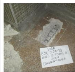
Foto 8 Exploración viga refuerzo superior. Edificio empleo.
