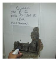
Foto 7 Edificio Empleo, Nivel 5. Exploración Columna B-2.
