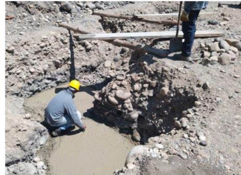
Solado para Zapatas
