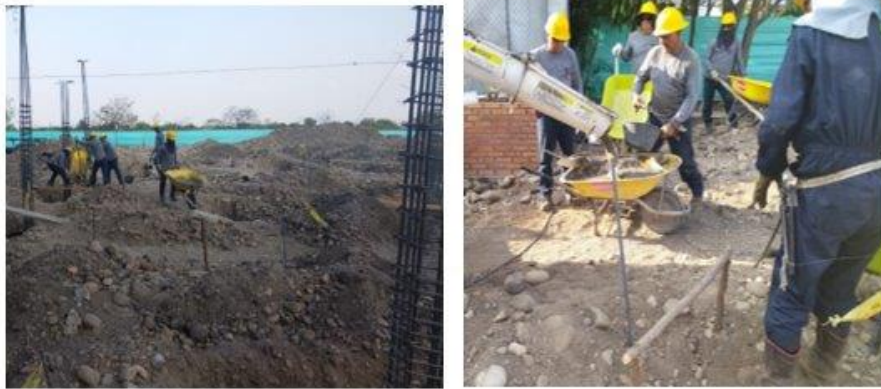
Construcción de Vigas de Cimentación
