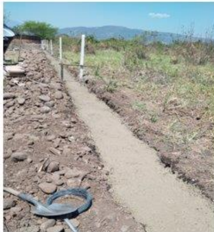
Solado para Cerramiento
