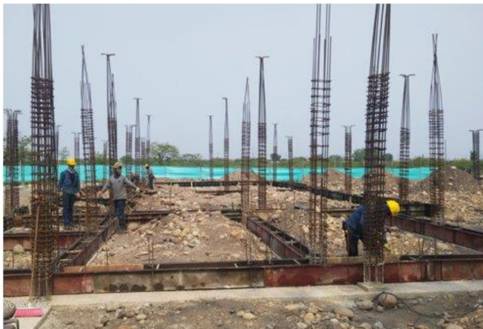
Construcción de Vigas de Cimentación
