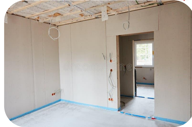
Evidencia calidad en acabados
