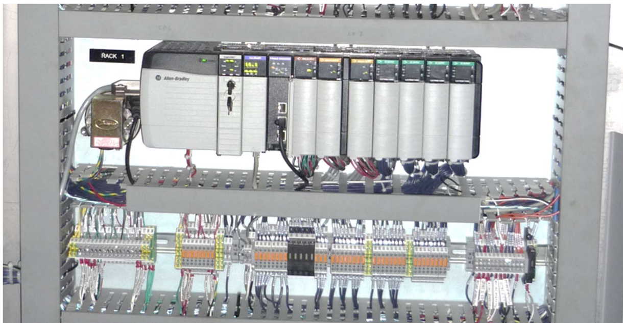
Figura 32. Activo Industrial (PLC) asignado al Extrusor EX2201
