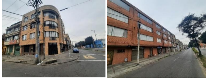
Calle 24 entre carreras 26 y 24
