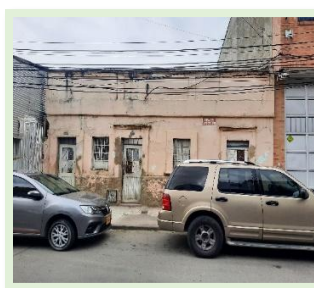
Carrera 26 con calle 22C
