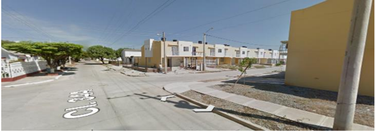
Fig. 25 Tipología predominante alturas de viviendas
