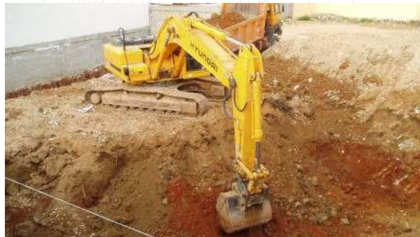
Excavaciones y Rellenos
