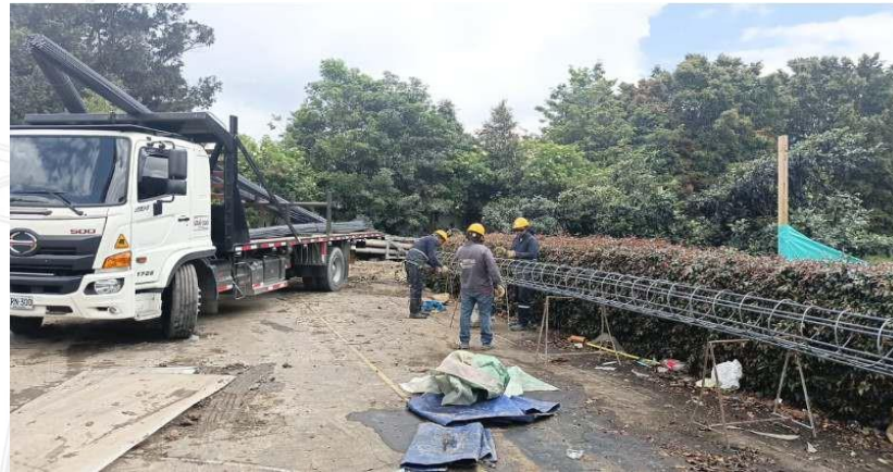
Pilotaje - Alistamiento de refuerzo
