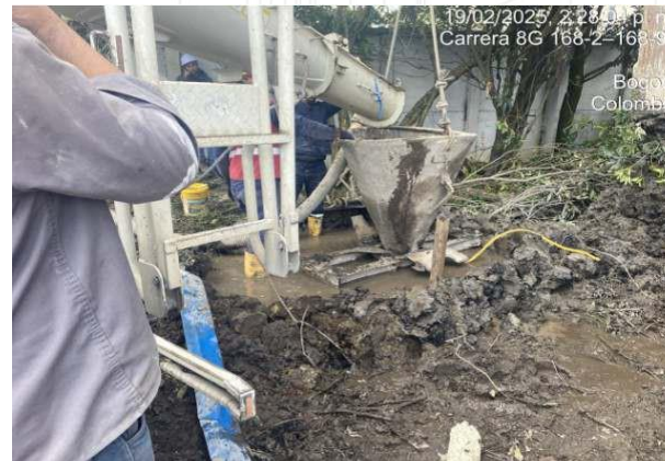
Construcción de Pilotes
