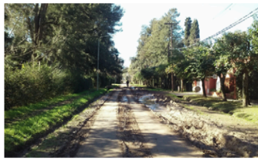
Figura 5. Camino embarrado luego de una lluvia en un barrio residencial
