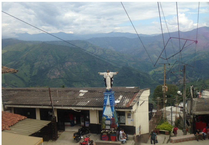
Figura N° 20. Fotografía del atrio en la parte alta del cerro, a donde fue trasladada la plaza principal de Marmato, después de la llamada ‘avalancha’. Fuente: Fotografía tomada por la autora.
