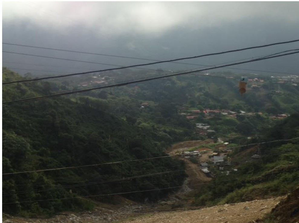
Figura N° 22. Fotografías de los cables en la parte alta del cerro. Fuente: Fotografías tomadas por la autora.
