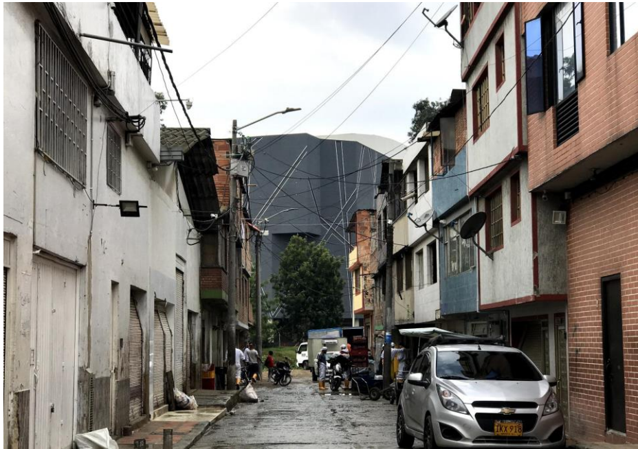
Al fondo el centro comercial Paseo Villa del Río con vista directa a El Mercado de carne
