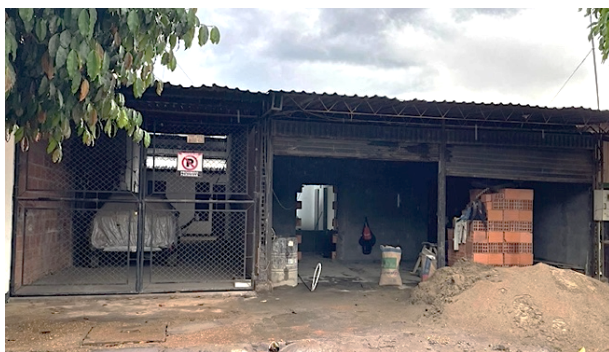
Figura 14 Vivienda sin remodelar proyecto Ecovida Vivienda sin remodelar proyecto Ecovida
