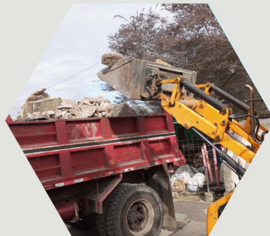
RETIRO DE ESCOMBRO Y SOBRANTES DE CONSTRUCCIÓN.
