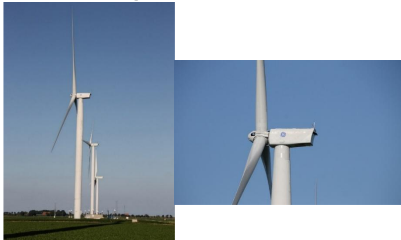
Figura 15. Fotos aerogenerador GE Vernova de 2,5 MW
