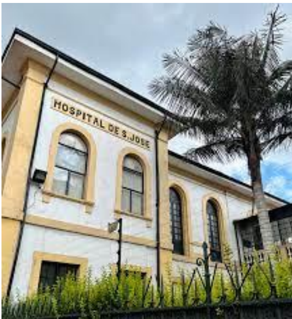
Figura 1: Fragmento de la fachada del Hospital San José.
