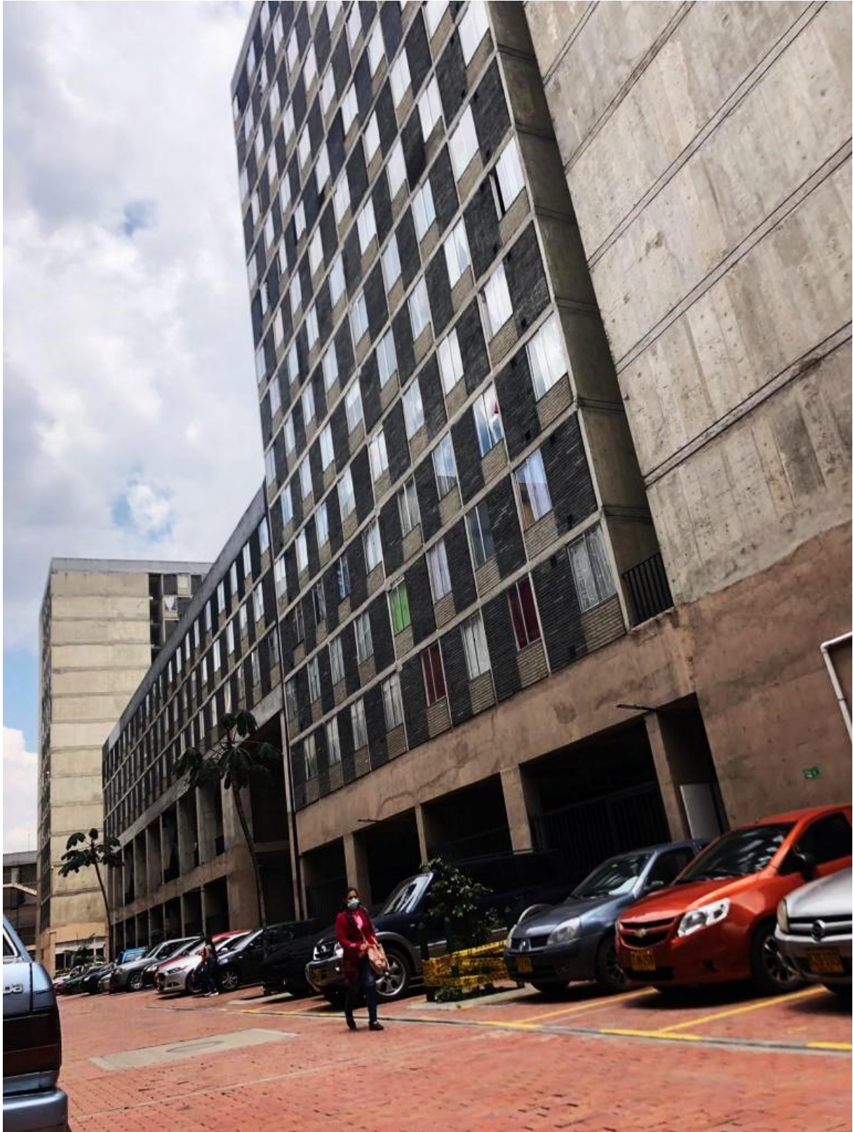
Fotografía 7: El primer piso de la Plaza de la Hoja con los espacios vacíos para locales comerciales. En el primer local ahora se está iniciando la producción de Pesto. Una de las cofundadoras me comentó que estaban preocupadas porque los carros les tapaban el negocio.
