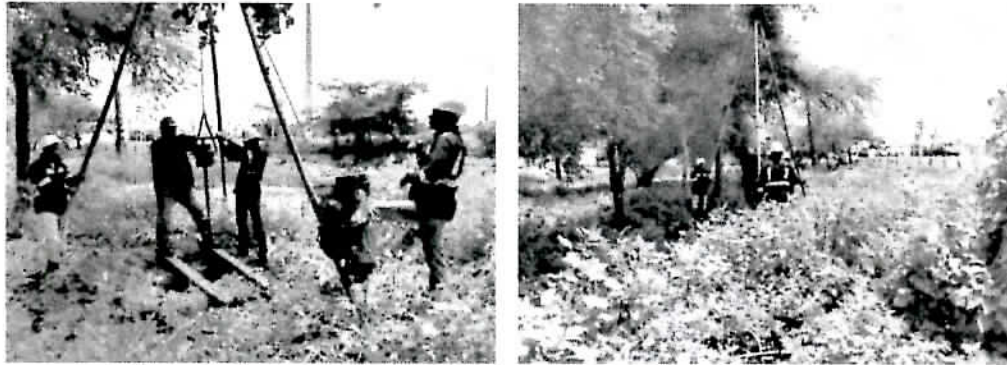
Sondeo 1. Ensayos finales de penetración estándar SPT
