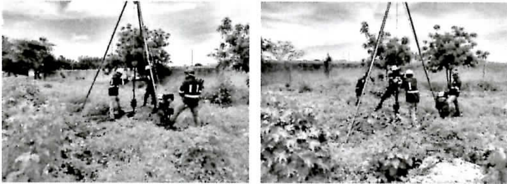
Sondeo 3. Ensayos finales de penetración estándar SPT
