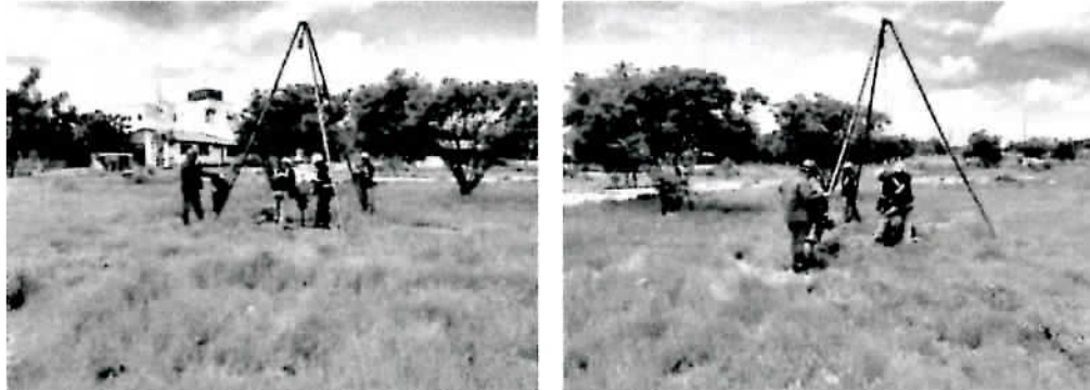
Sondeo 5. Ensayos finales de penetración estándar SPT
