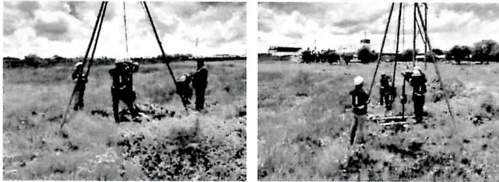
Sondeo 4. Ensayos finales de penetración estándar SPT
