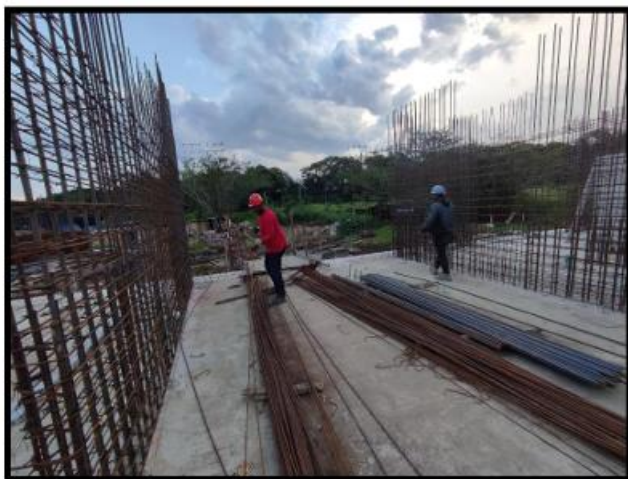
Foto No.01 (01 de abril de 2026): Piso 3, actividades de armado de refuerzo de muros.
