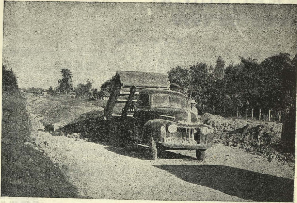
Un aspecto de los trabajos de rectificación, ampliación y pavimentación de la Carretera Crucero de Candelaria-Florida-Pradera-Palmira, que se adelantan actualmente por cuenta de la administración que preside el doctor Diego Garcés Giraldo. (Foto Información.)
