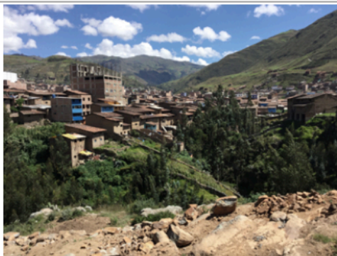
Vista de la ciudad de Otuzco, 2016
