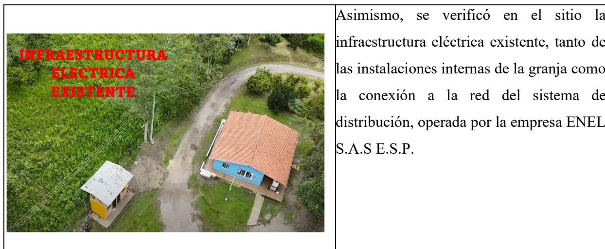
Ilustración 11. Registro fotográfico e identificación conexión eléctrica.
