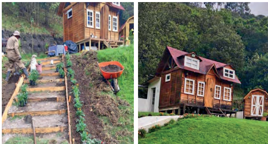
Figura 7.4. Construcción de una cabaña sobre pilotes
