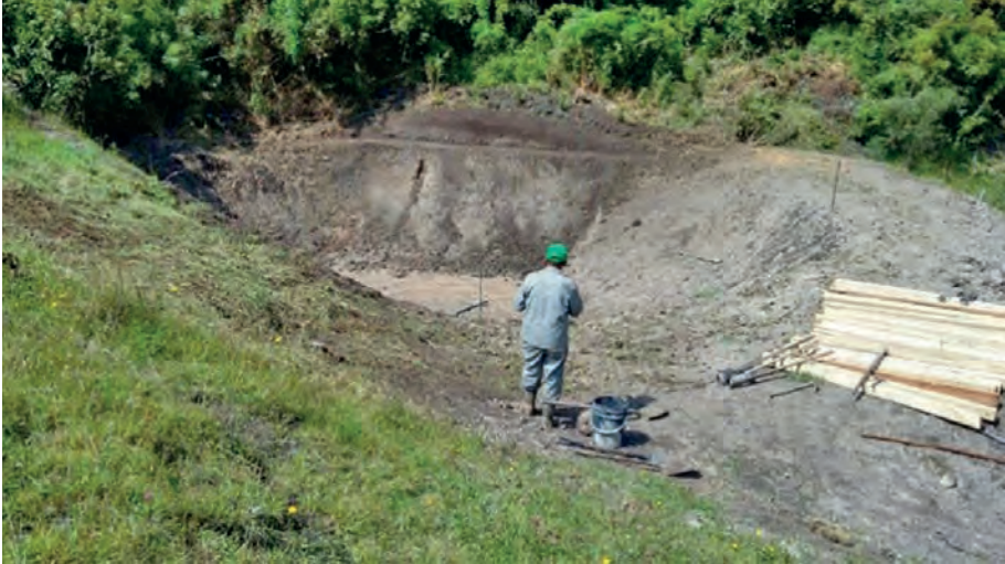
Figura 7.2. Desarrollo de un reservorio mediante el uso de geomembrana
