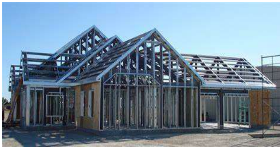
Ilustración 4. Vivienda Steel Frame
