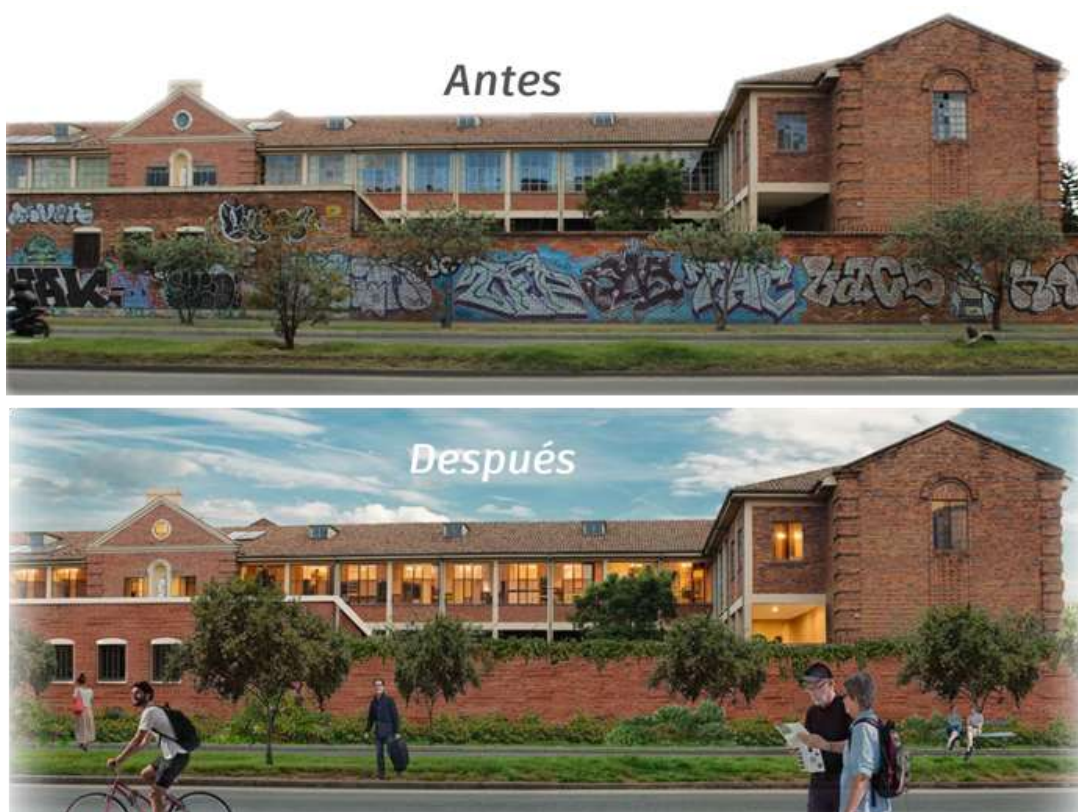
Figura 49. Intervención B.I.C Antes y Después.
