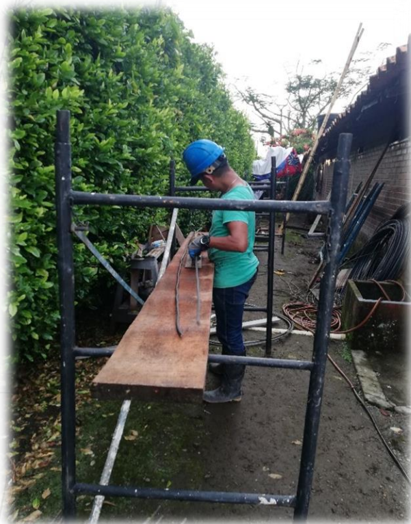
Uso adecuado de EPP
