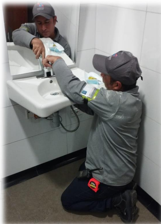
Sustitución de aparatos sanitarios (Lavamanos)
