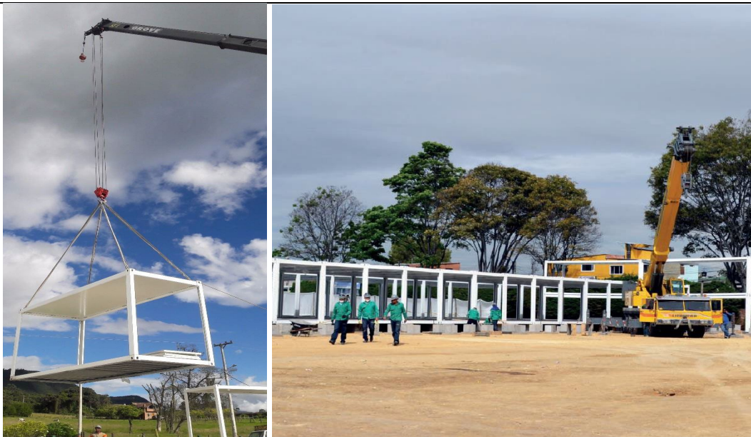
Figura 6. Proceso de izaje e instalación
