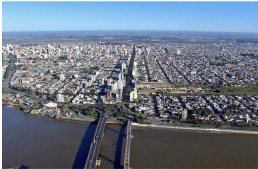
Figura 5. Construcción de torres en las inmediaciones de la ex estación Belgrano
