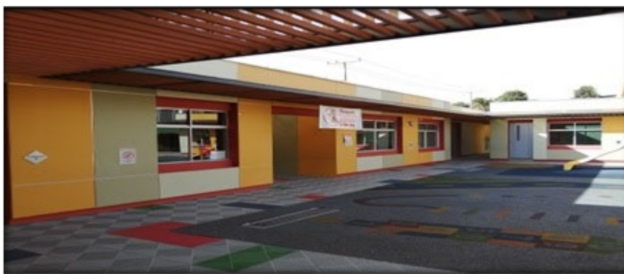
Figura 12. Fachada actual del edificio Asturias
