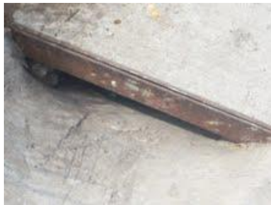
(Gestión de obras y arreglos) Fotografía tomada por el autor del presente trabajo de Grado. Diciembre 2013
