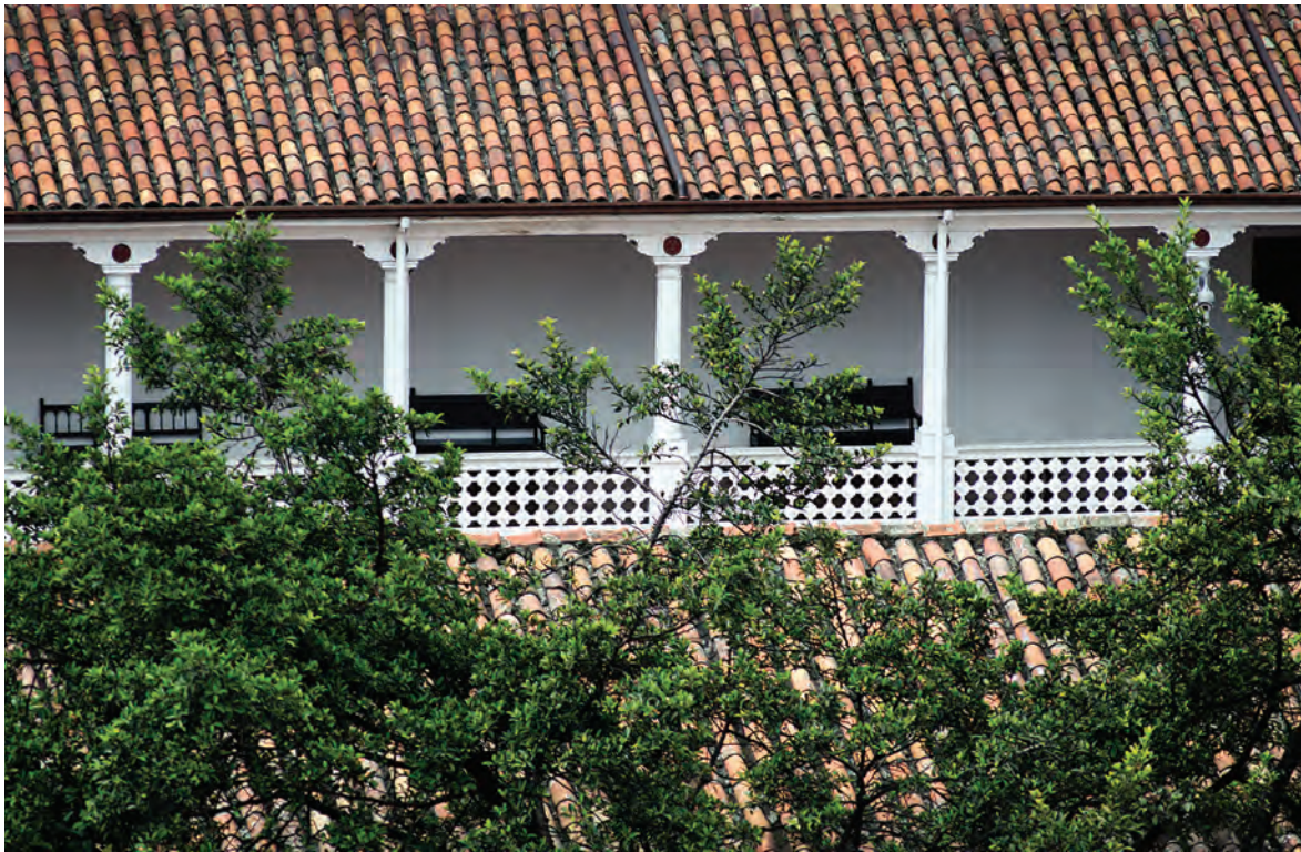
Cubiertas del Claustro. Roofs of the Cloister.
