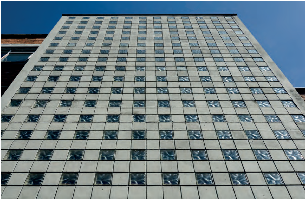
Detalle del muro exterior de una de las edificaciones en la Quinta de Mutis. Detail of the exterior wall of one building in the Quinta de Mutis.
