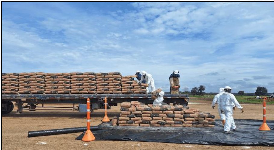
Acopio de Cemento para la construcción obras en ccto.
