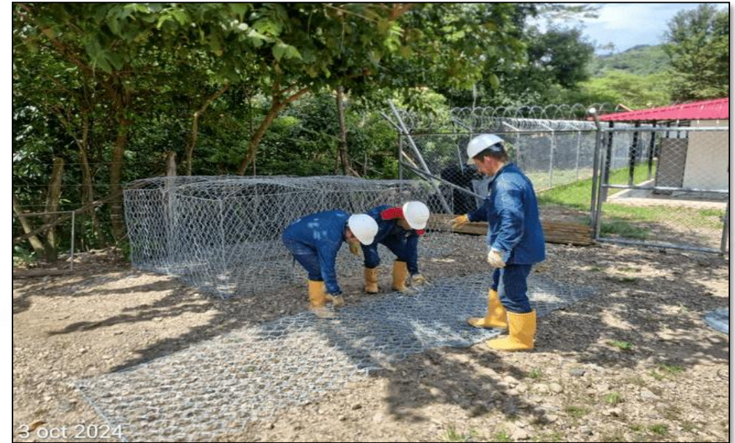
Acopio de malla gavión
