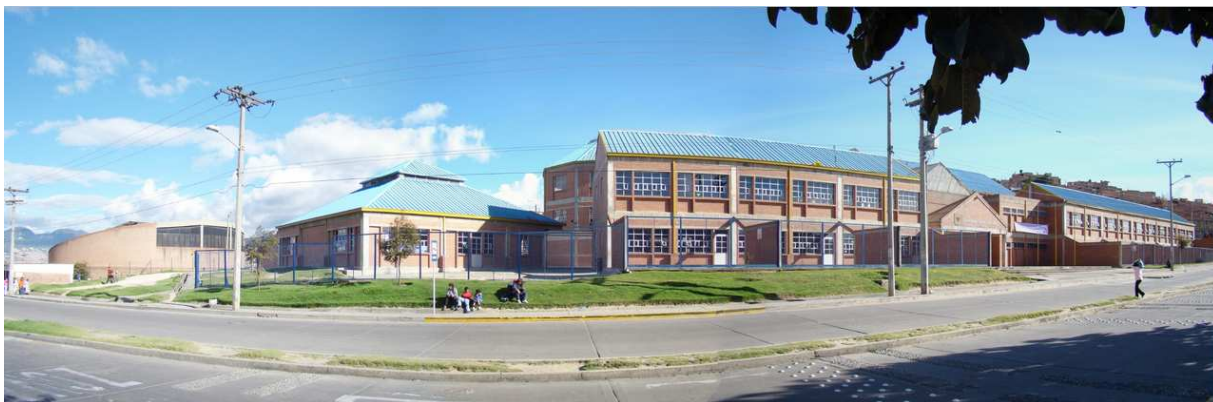
Figura 4: Fachada Gimnasio Sabio Caldas
