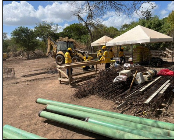
Tendido de tubería
