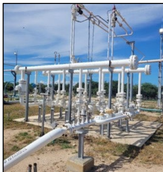
Figura 18. Sistema de Manifold de recibo de gas y Sistema de deshidratación
