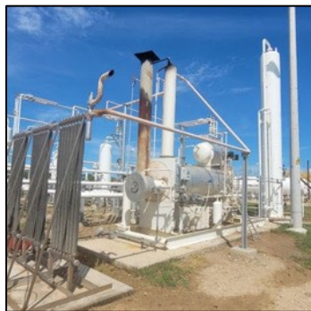
Figura 19. Sistema de ajuste punto de rocío HCDP
