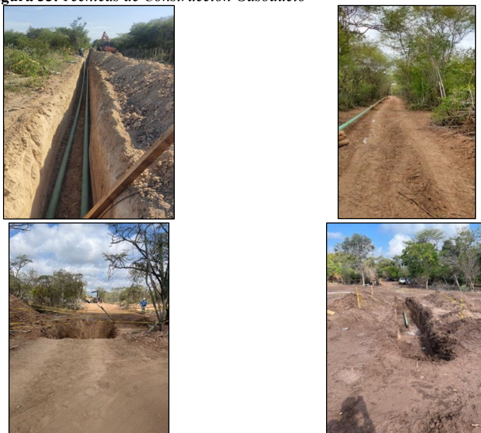
Figura 33. Técnicas de Construcción Gasoducto
