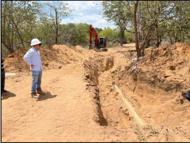
Instalación de tubería
