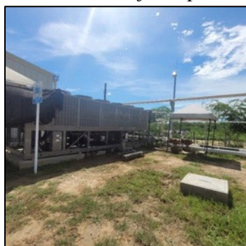
Figura 19. Sistema de ajuste punto de rocío HCDP
